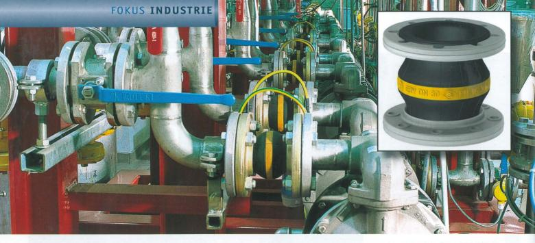
Gummikompensatoren, wie hier in einer Pumpenanlage, dienen als flexible Rohrleitungselemente, die unter anderem Dehnungen, Geräusche und Vibrationen aufnehmen.
