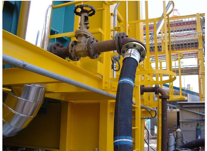
UTS Schlauchleitung / im Dauerbetrieb, Alkalilösung
